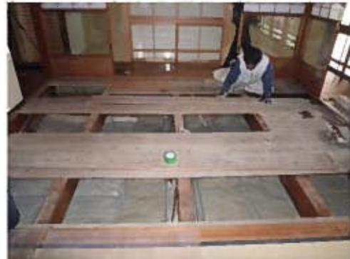
写真4. 断熱材設置後
