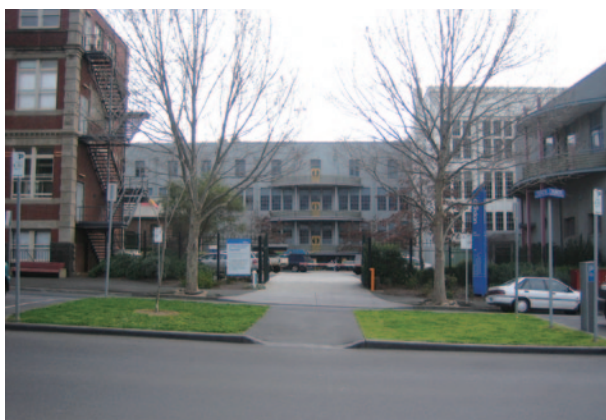
ゴードン・インスティテュート・オブ・ティフ正門
