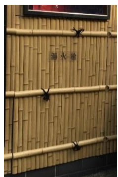
▲景観に配慮された消火栓
