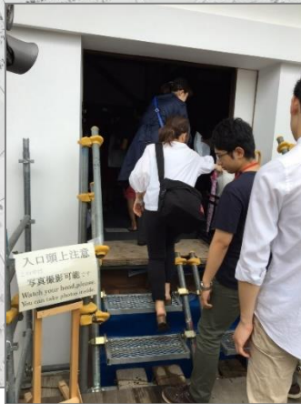
(中) 工事中の東大手門への現地調査
