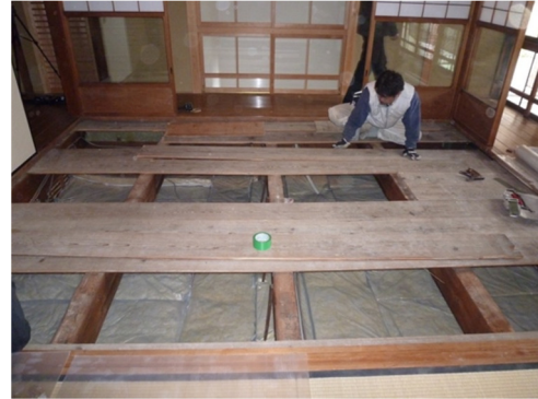
写真4. 断熱材設置後
