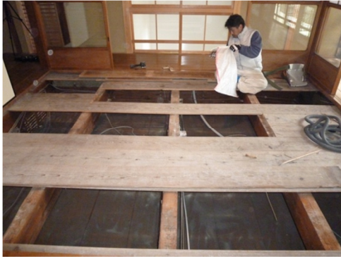
写真3. 断熱材設置前
